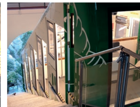
LEITNER SpA – Telefericos Y Nieve - Compoceal AL Vettura in fase di cantiere
